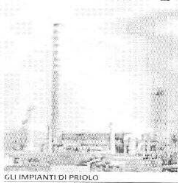
GLI IMPIANTI DI PRIOLO
